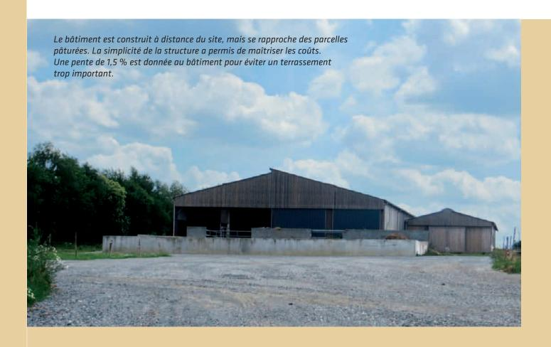
Le bois reste bien présent en bardage ajouré à l'arrière et en bardage jointif en façade sous la tôle perforée. Les poutres lamellé-collé reposent sur des poteaux métalliques pour dégager l'espace pour le travail dans le bâtiment.
